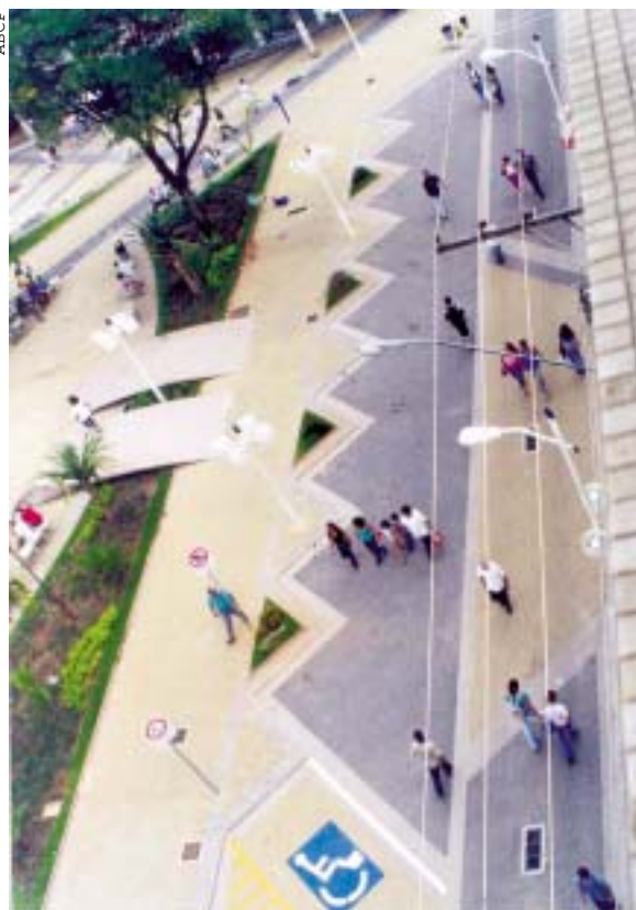
Uso de “blokret” em passeio na cidade de Jundiaí
