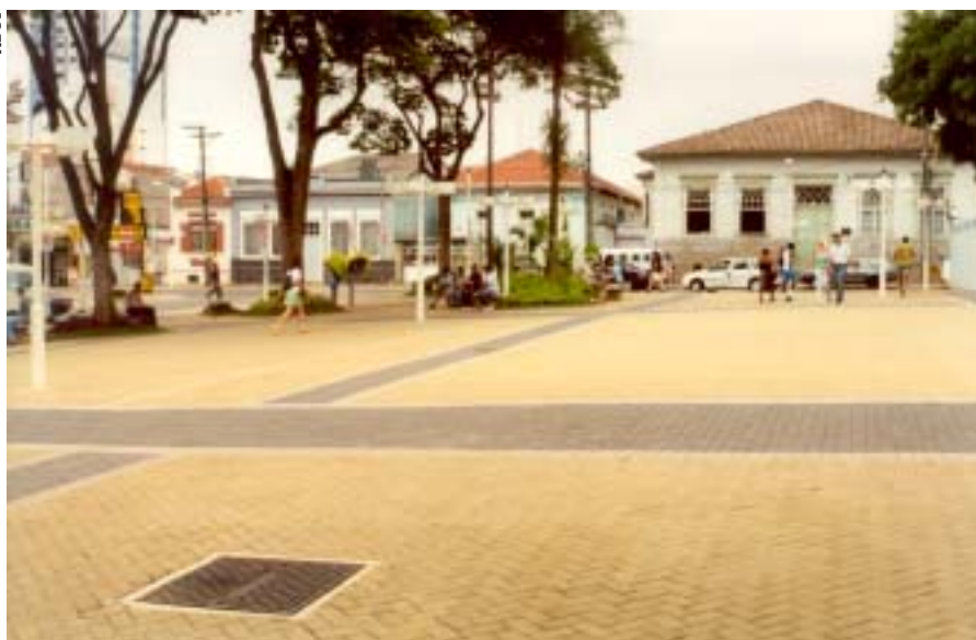
Calçadão em Jundiaí: blocos articulados ajudam o escoamento das águas
